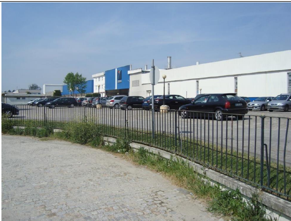
Figura 6: Área da expansão prevista (vista de Sudoeste para Nordeste)
